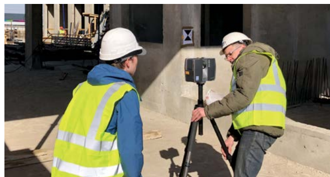
Процесс лазерного сканирования здания инвест-отеля IN2IT
